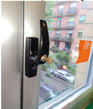
(foto 1) maniglia con "manovra logica" dotata di chiave di sicurezza
