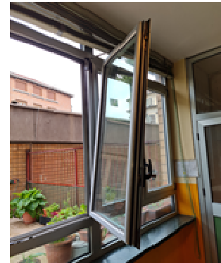
(foto 3) SITUAZIONE DI PERICOLO finestra anta-ribalta aperta in "falsa manovra" sia ad anta che a ribalta
